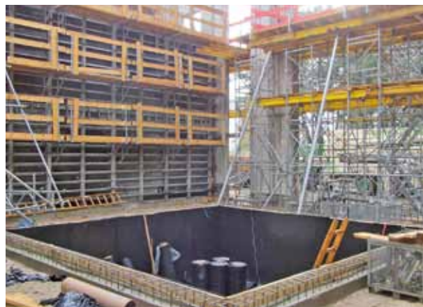
エアバスA400Mフライトシミュレーター、ヴンストルフドイツ: Regupol® 機械基礎の全面デカップリング (分離)
