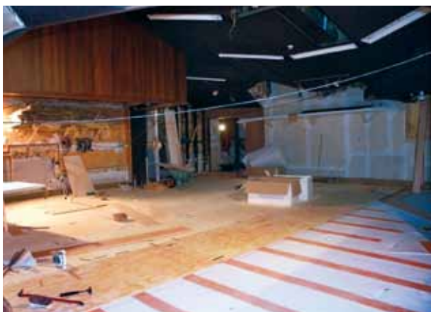
Wisselord-スタジオ、ヒルフェルスム、ネザーランド: Regufoam® による室内浮床衝撃絶縁
