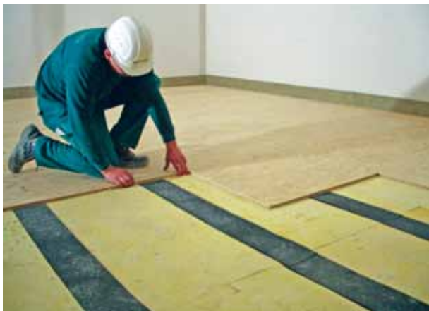
RTL-スタジオ、ケルン、ドイツ: Regupol® による室内浮床衝撃絶縁
