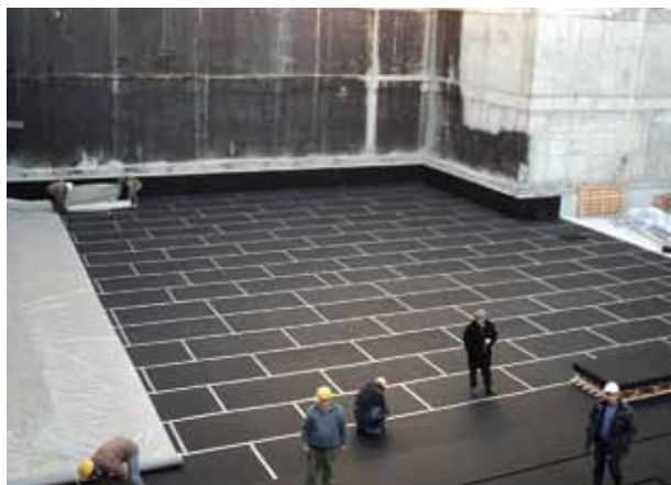
AGBU行政ビル、エレバン、アルメニア: Regupol® による建築基礎全面デカップリング (分離)
