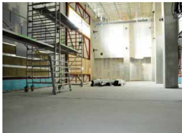
エルブフィルハーモニー、ハンブルク、ドイツ: Regupol® によるコンサートホール及びスタジオ浮床衝撃絶縁
