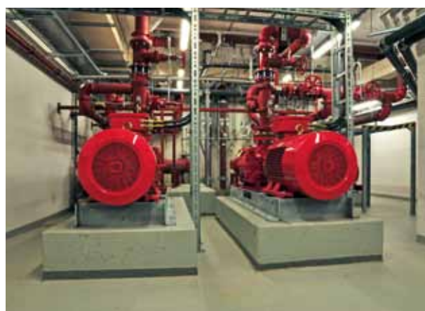
Nexttower、Palaisquartier、フランクフルト、ドイツ: Regupol® による暖房、換気、および空調の防振
