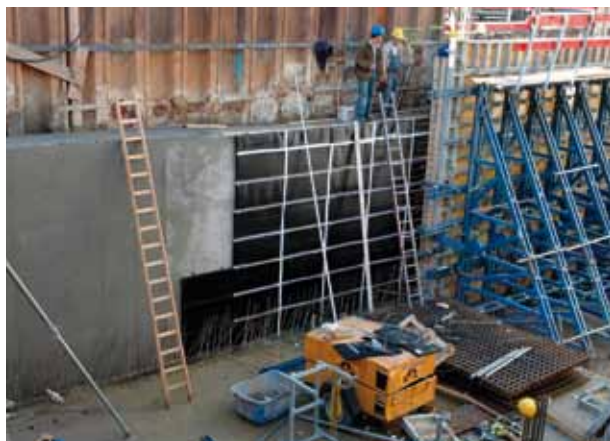
裁判所、ミュンヘン、ドイツ: Regupol® 建築基礎垂直デカップリング (分離)
