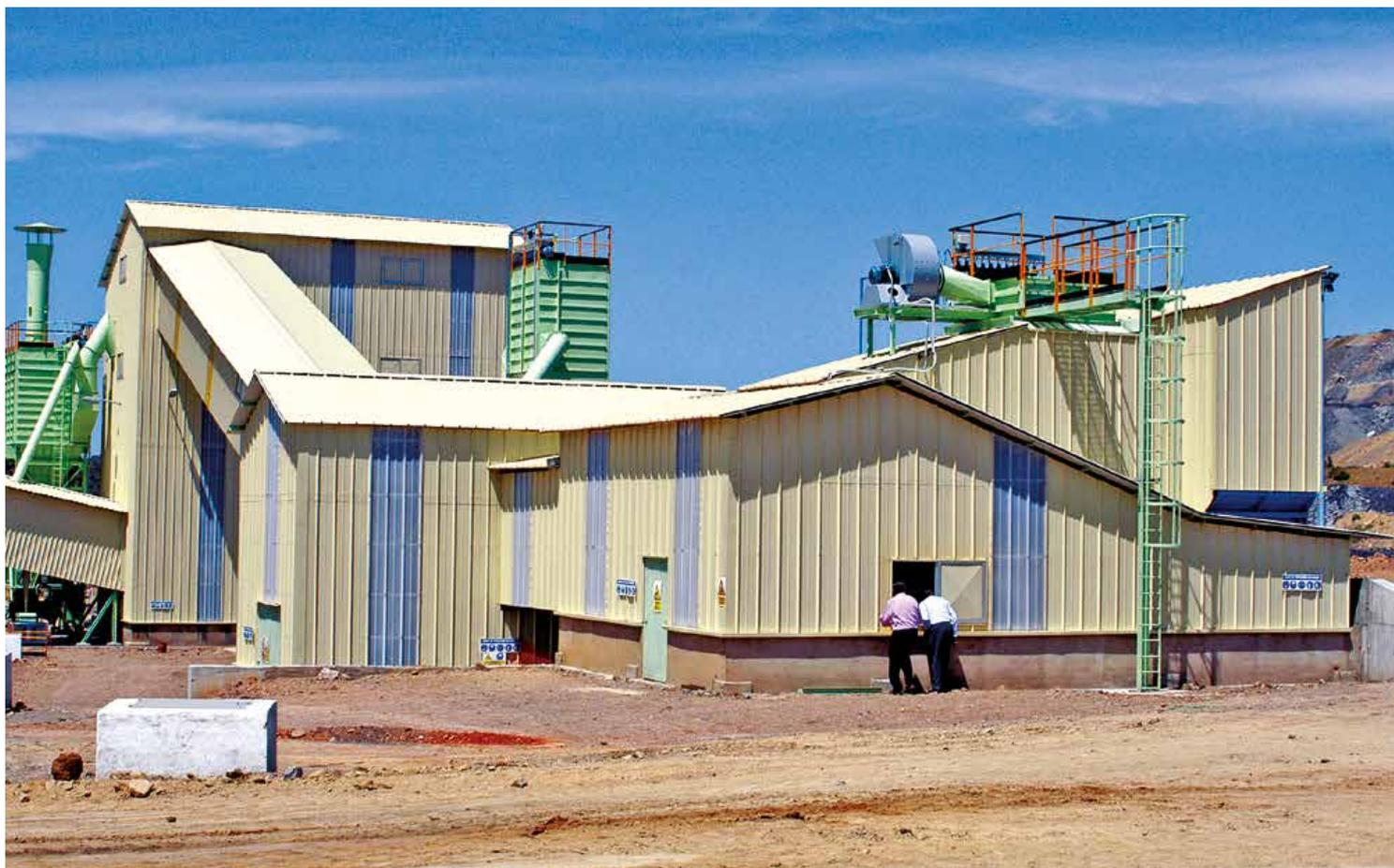
隣接する露天石炭採掘場より採掘した状態の原石を直接受け入れる、石炭処理プラントと一体化したSamson®マテリアルフィーダーのエンクロージャー
