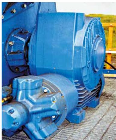
現場又は遠隔の油圧動力ユニットを備えたダイレクトカップリングの油圧モータードライブでは、電動モーター及び制御機器は、アクセス容易な位置にフィーダーとの適当な間隔で設置されます。
