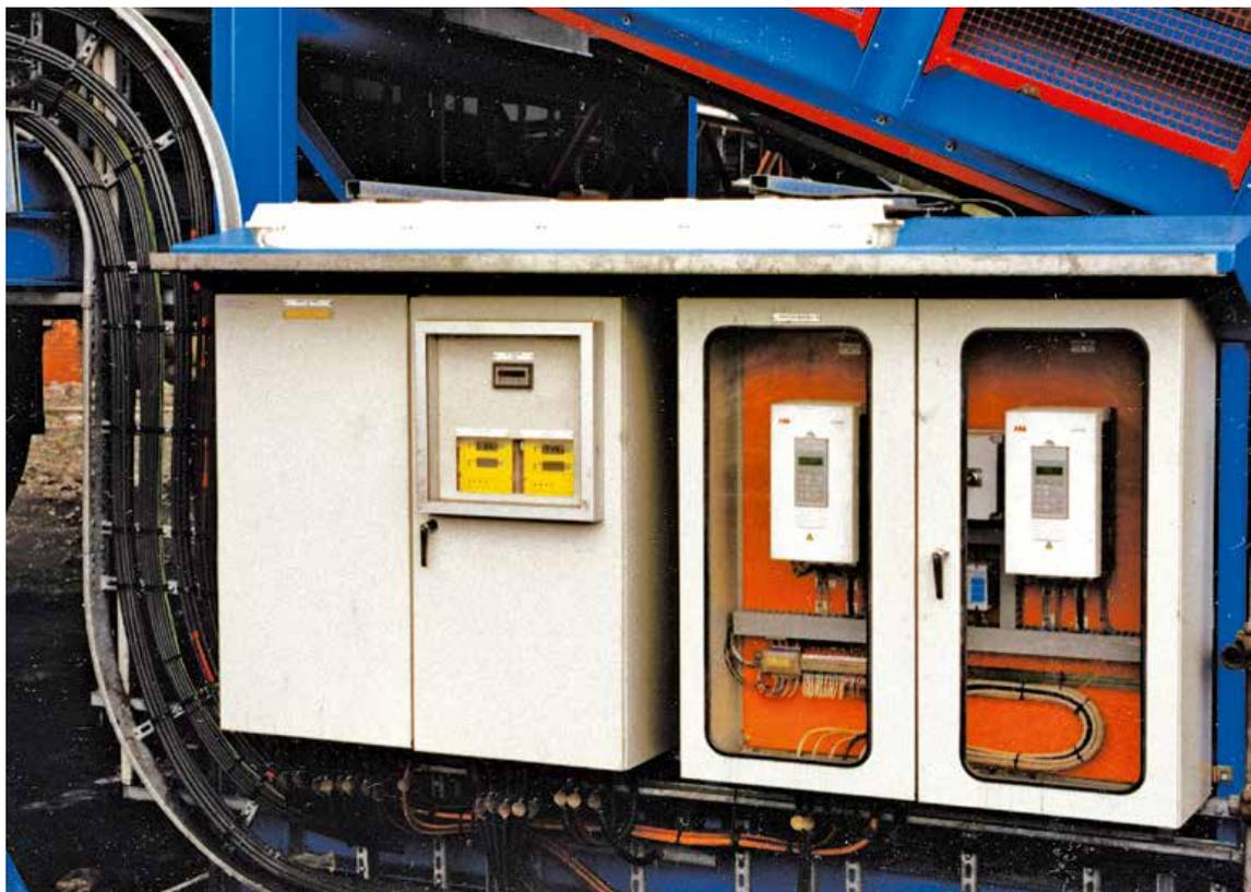
Samson®マテリアルフィーダーの設置場所に設置され、遠隔制御室と接続される、インバーター速度制御モジュール
